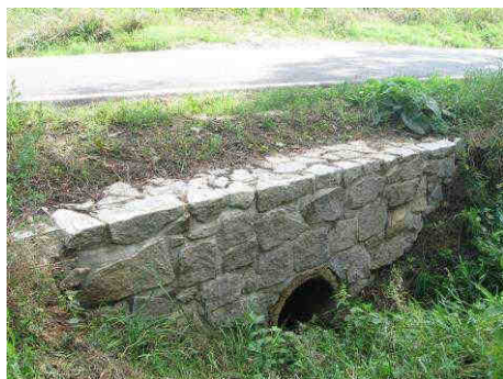
Silniční propustek DN 2,0m na LB přítoku – po toku
