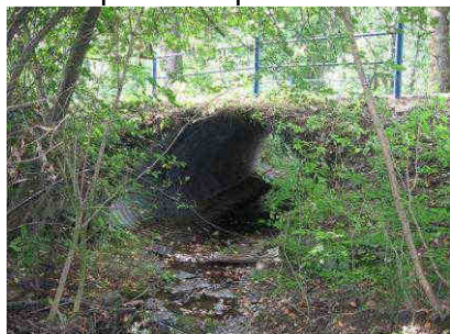
Silniční propustek DN 2,0m na LB přítoku – po toku
